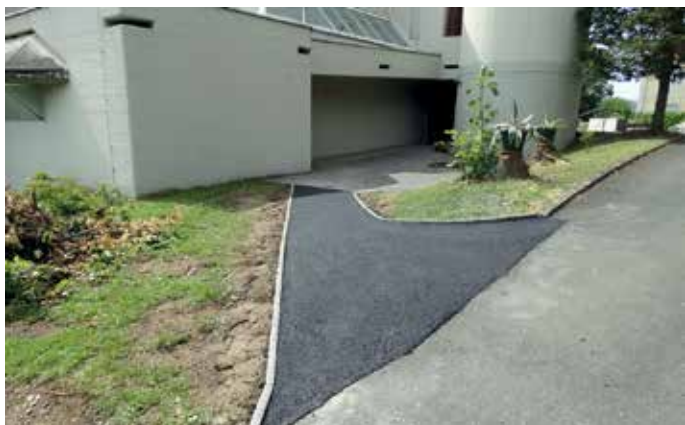
Erneuerung des Weges zur Sakristei
