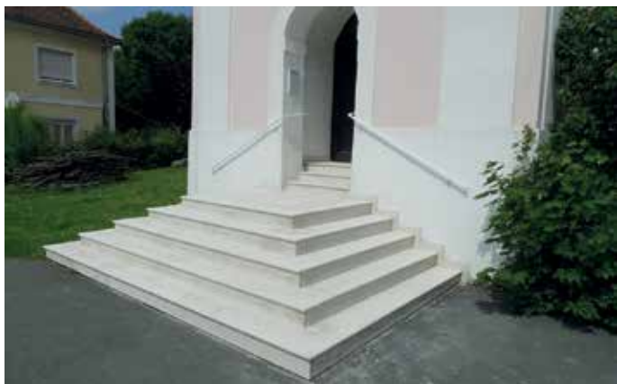
Erneuerung der Stufen beim Eingang zur alten Pfarrkirche
