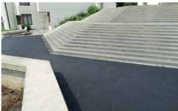
Erneuerung des Podestes bei den Stufen zur Osterkirche
